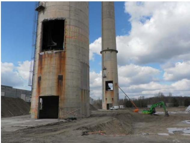
In der Mitte der vorgesehenen Fallrichtung verlief ein elektrisches Mittelspannungskabel und auf der rückwärtigen Seite eine wichtige Wasserleitung.
