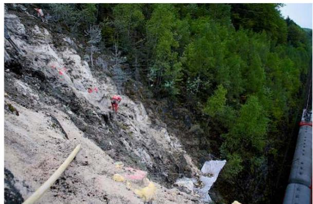
1.775 kg Ammon - Gelit (Ø 50 mm) wurden in die 127 Bohrlöcher zusammen mit 942 m 12g-Sprengschnur geladen. Die spezifische Lademenge betrug 0,368 kg/m<sup>3</sup>.
